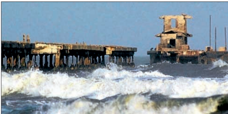
Foto 2. Muelle de Puerto Colombia
