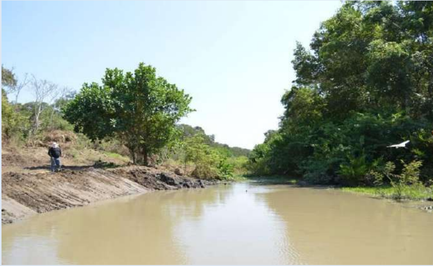
COMENTARIOS: Perfilación de taludes en el caño el Torno
