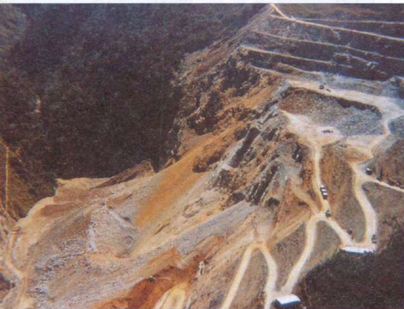
Las hidroeléctricas destruyen el paisaje al tiempo que aportan para su conservación.
